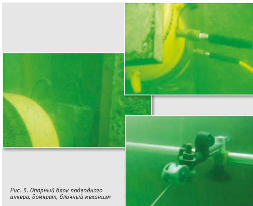
Рис. 5. Опорный блок подводного анкера, домкрат, блочный механизм
