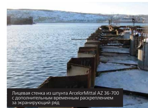
Лицевая стенка из шпунта ArcelorMittal AZ 36-700 с дополнительным временным раскреплением за экранирующий ряд
