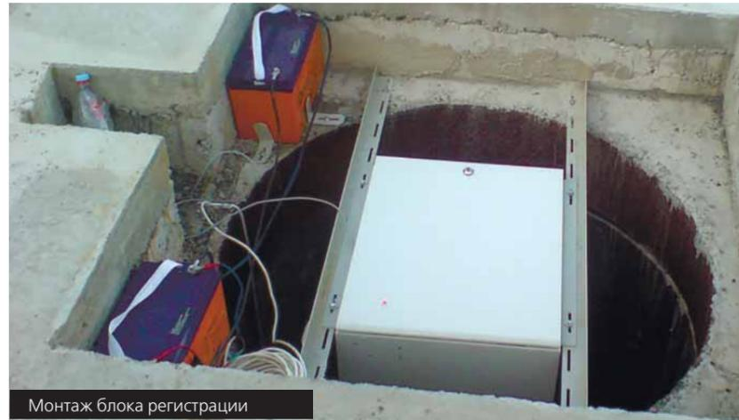
сооружений эстакадного типа. Разработанная система фиксирует перемещения ростверка и отклонения свай от оси при динамических и статических нагрузках. Данные мониторинга передаются по каналам GPRS в головной офис организации.
