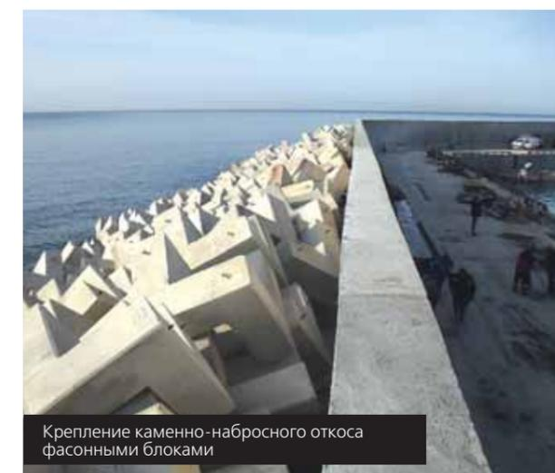
Крепление каменно-набросного откоса фасонными блоками
