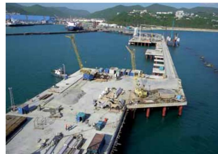
Реконструкция разрушенного Первомайского волнолома и восстановление профиля сооружения до проектной отметки плюс 4,30 м позволяет существенно улучшить волновой режим от штормов ЮЗ – ЮЮВ направлений не только на операционной акватории причального комплекса 1А, но и на внутренней акватории порта.
