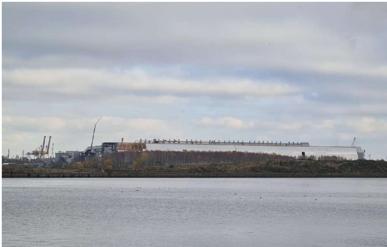
Балтийский балкерный терминал – 3 склад удобрений
