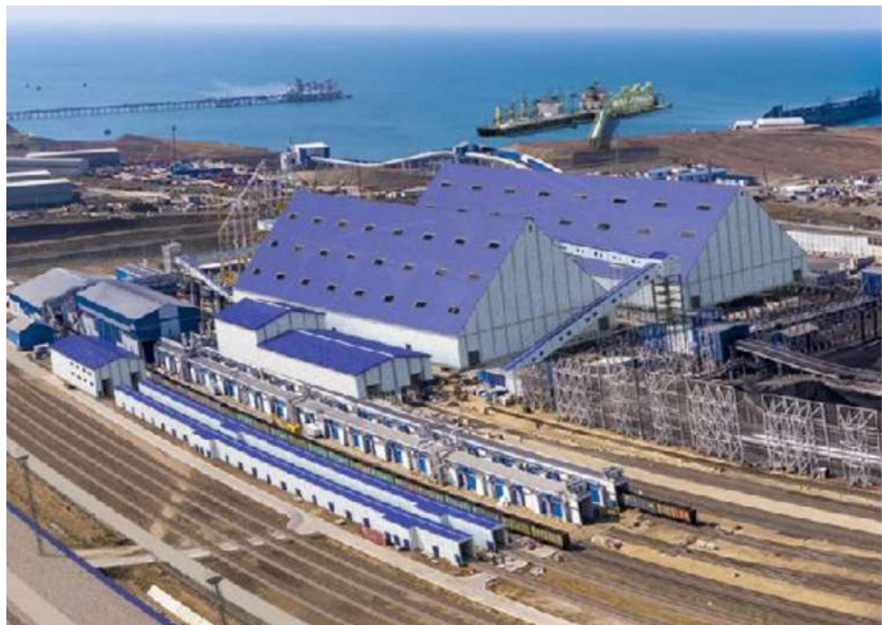
Строительство склада удобрений терминала «ОТЭКО»
