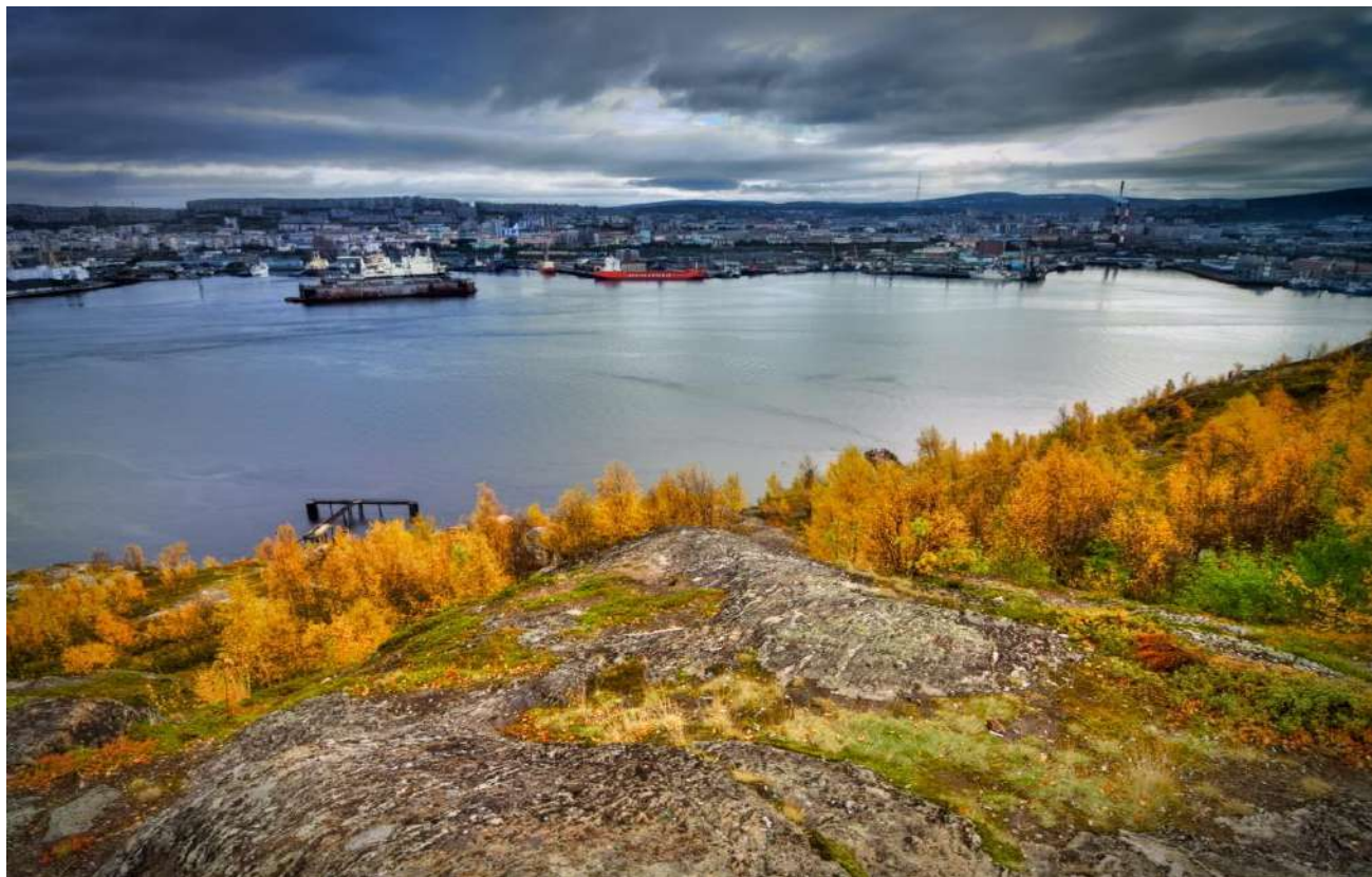
Вид с перспективной площадки строительства нового перегрузочного комплекса
