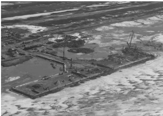
Рис. 5. Вид на пирс Салмановского (Утреннего) НГКМ в процессе строительства (фото 04.06.2015 г.)
