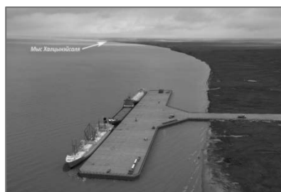
Рис. 2. Пирс Салмановского (Утреннего) НГКМ в районе мыса Халцынэйсаля Обской губы (вид с юго-востока)
