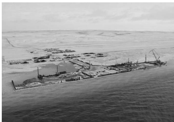
Рис. 4. Вид на пирс Салмановского (Утреннего) НГКМ в процессе строительства (фото 15.10.2014 г.)
