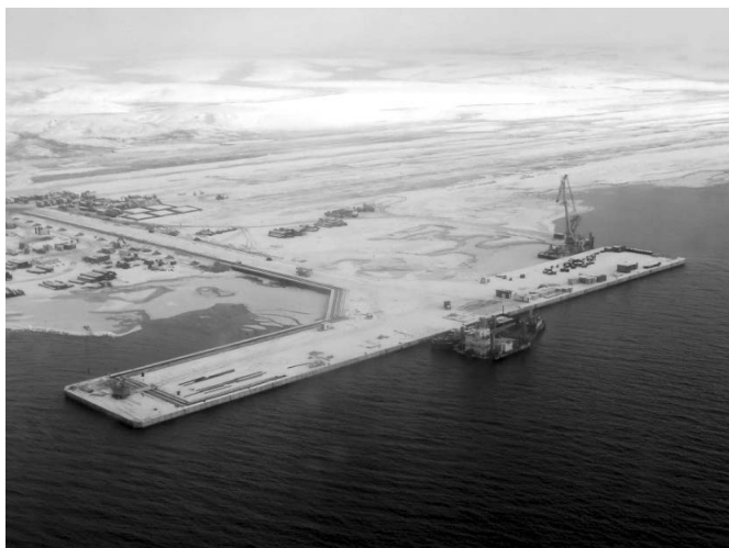
Рис. 6. Вид на пирс Салмановского (Утреннего) НГКМ по окончании строительства (фото 11.11.2015 г.)
