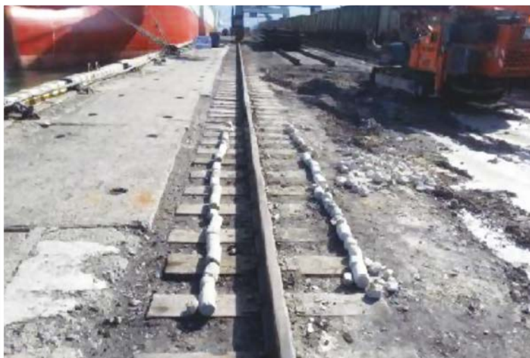
Рис. 5. Вид выбуренных кернов из колонны №13 (опытный участок №2). Образцы в количестве 98 шт. в возрасте 28 суток испытаны в независимой испытательной лаборатории
