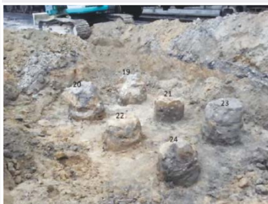
Рис. 3. Опытный участок №2. Вид голов грунтоцементных колонн, выполненных по технологии Jet-1 (диаметр 0,5–0,6 м)
