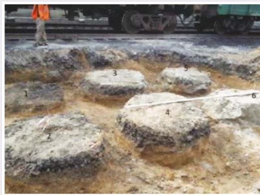
Рис. 2. Опытный участок №1. Вид голов грунтоцементных колонн, выполненных по технологии Jet-2 (диаметр 1,15–1,3 м)
