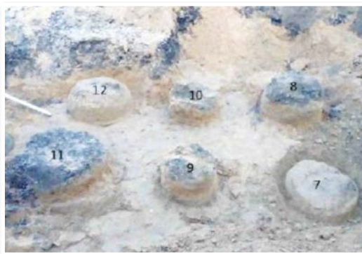
Рис. 1. Опытный участок №1. Вид голов грунтоцементных колонн, выполненных по технологии Jet-1 (диаметр 0,5–0,6 м)
