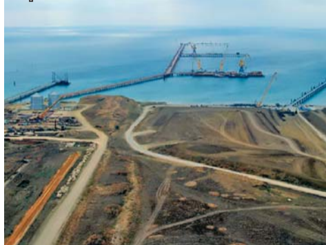
Строительство морского порта Тамань.
